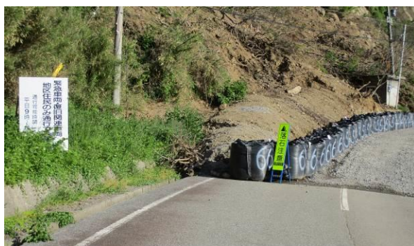
⑦一時孤立状態となった男性から話を聞く（輪島市門前町深見地区）
