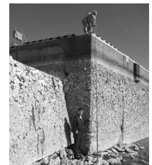
約4メートル海岸隆起した鹿磯漁港（輪島市門前町）
